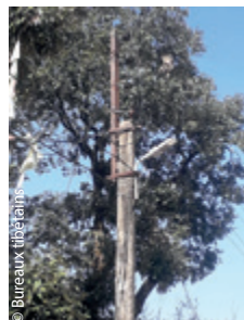
Poteau électrique à réparer à Upper TCV de Dharamsala !
