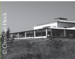
Le bâtiment des communs, Université de Bangalore.
